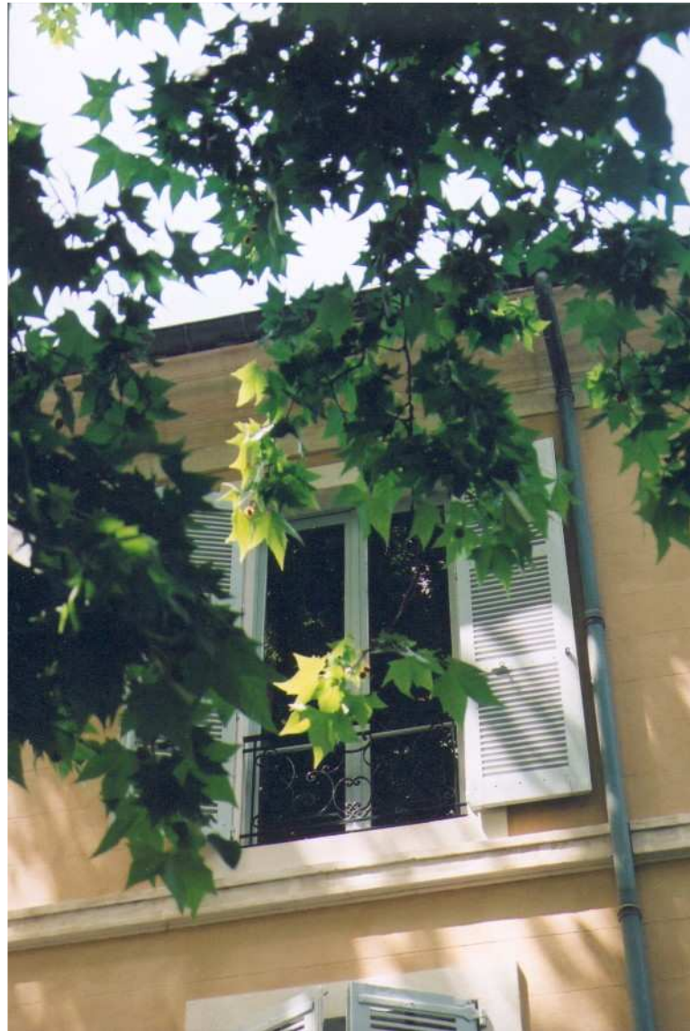
Façade donnant sur le quai de la Fontaine, détail : une des fenêtres du 2 nd étage au garde-corps inspiré par les ferronneries du XVIIIe siècle
