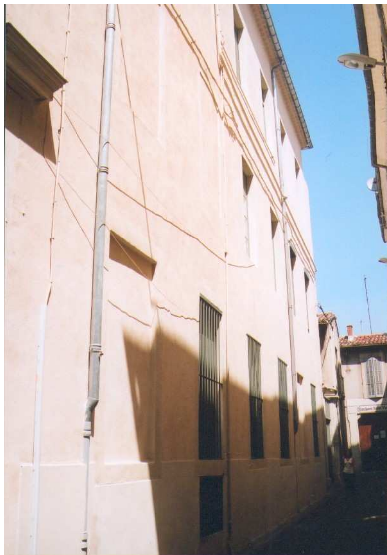
Façade donnant sur la rue de la Parisière
