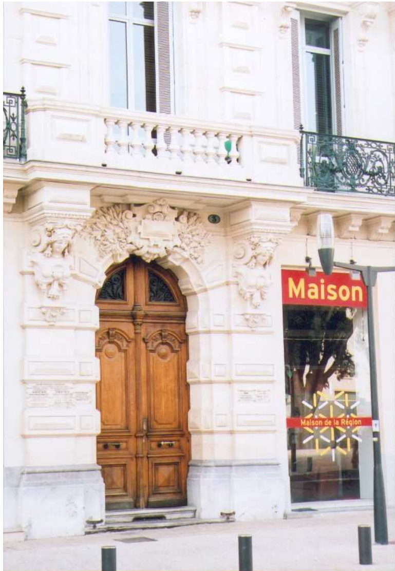
Détail de la façade : entrée
