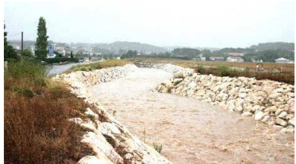
Arrivée des eaux du cadereau du Valladas dans le bassin de l'aérodrome le 6 septembre 2005. (les 6 et 8 septembre 2005, le stockage effectué par l'aérodrome a été de 280 000 m 3 )
