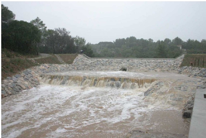
Digue du bassin de Pierre-Blanche le 6 sept. 2005.
