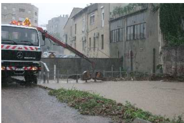
Enlèvement de « flottants » aux grilles d'un engouffrement de cadereau
