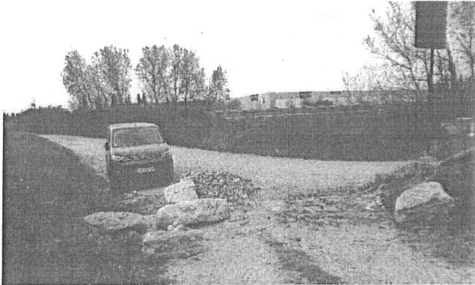
Blocs de pierre limitant normalement l'accès situé au nord du bassin, déplacés et non fonctionnels – CBE, 26 mars 2021
