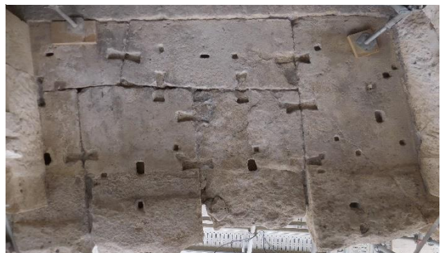
Figure 2 : Vue du dessus des emplacements des crampons qui relient deux blocs entre eux © Inrap
