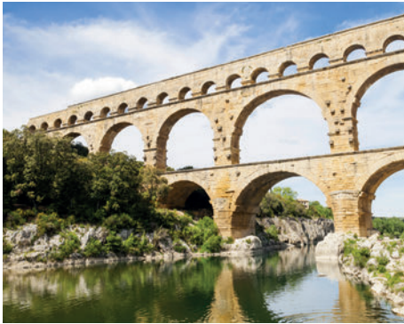
Le pont du Gard franchissant la vallée du Gardon © Aurelio RODRIGUEZ
