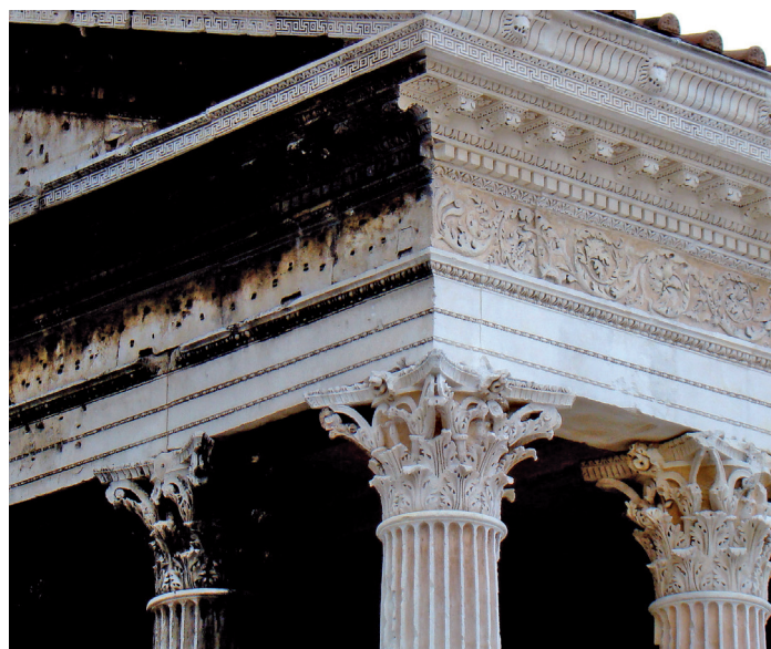
Avant et après restauration Before and after restoration
