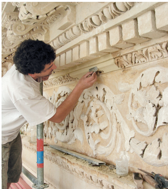
Opération de restauration de la frise Restoration operation of the frieze
