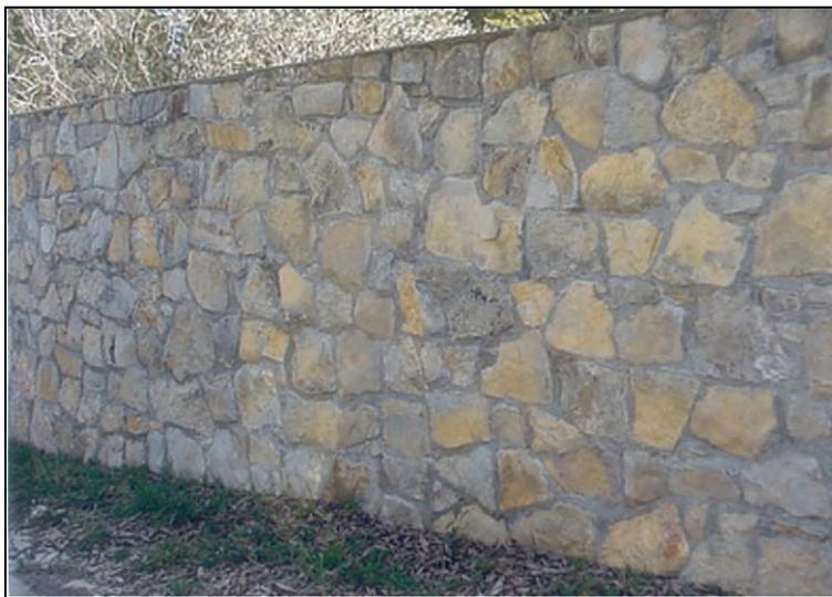
Appareillage de pierres de grande dimension ( type cyclopéen )
