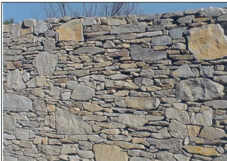
Appareillage à joints secs avec quelques grosses pierres sèches
