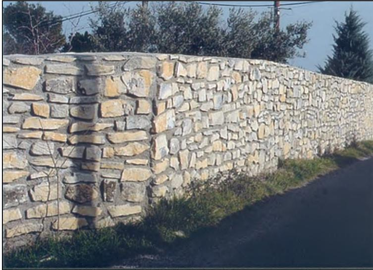
Appareillage à joints de mortier
