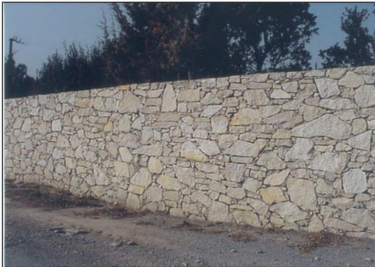
Appareillage à joints secs trop réguliers
