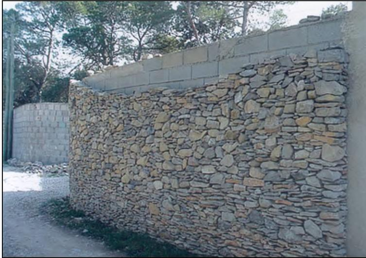
Mur de clôture en pierres sèches en plaquage sur un mur en agglo.
