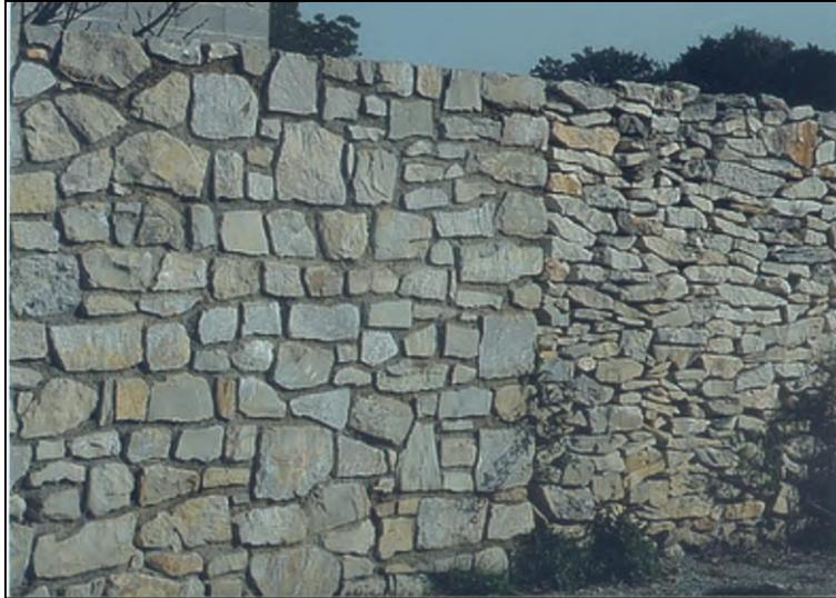
Mur de gauche : appareillage à gros joints de mortier **NON RECEVABLE**
